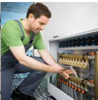
Inbetriebnahme des EMPUR® GeniAx Wärmeverteilsystems
