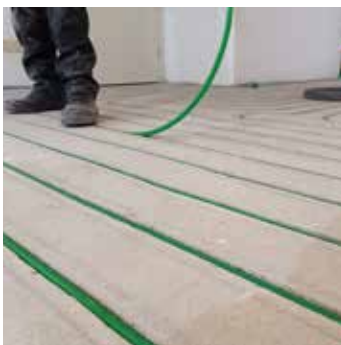
Montage der Flächenheizung (z.B. CUT-THERM®)
